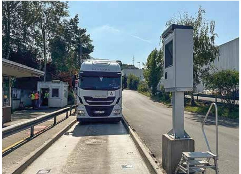
*Eine Straßenfahrzeugwaage bildet häufig die zentrale Grundlage für präzise Betriebsabrechnungen.*
